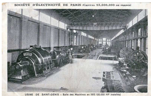
Carte postale ancienne éditée par la Société d'Electricité de Paris montrant la salle des machines de son usine de La Plaine Saint Denis en 1912
